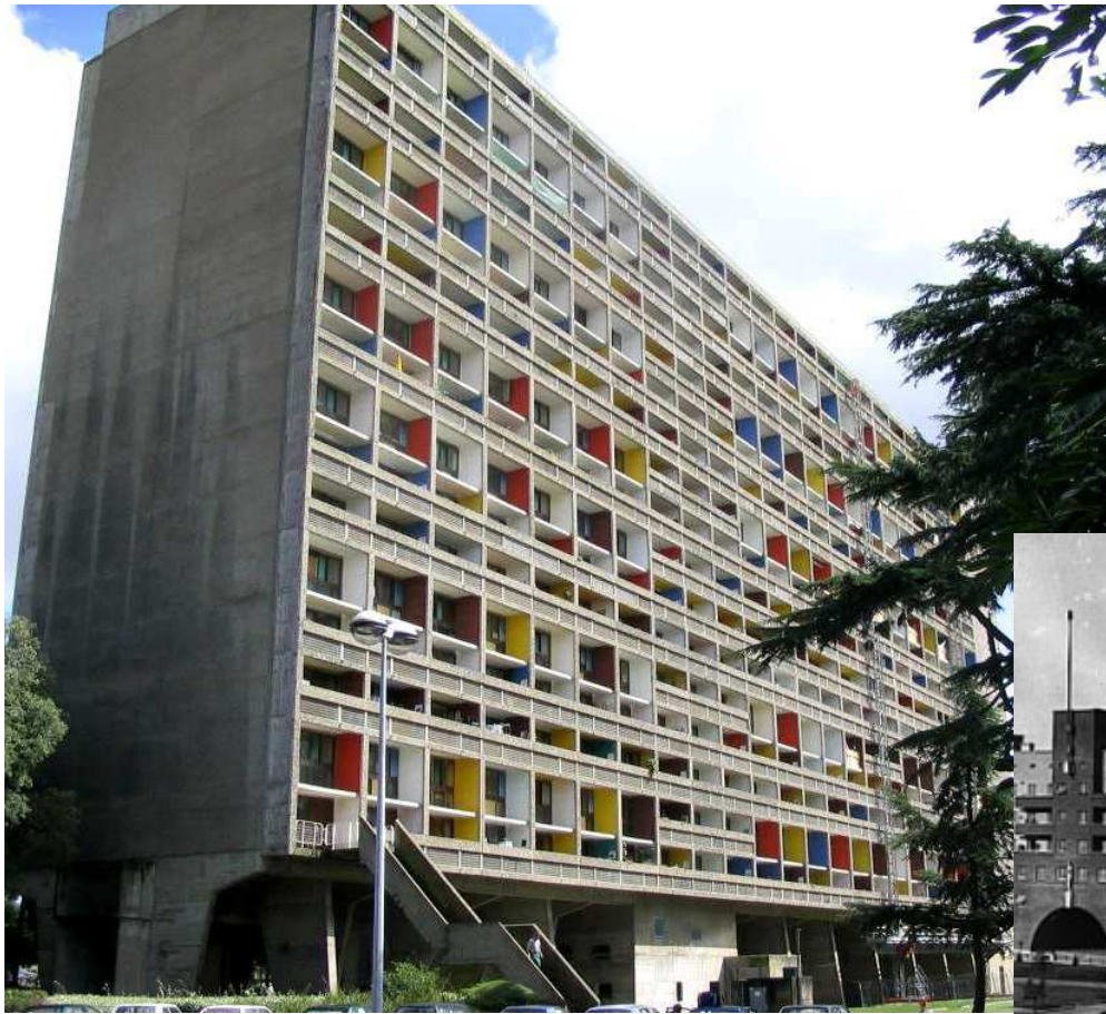
Cité Radieuse (Marseille, Rézé) Le Corbusier
